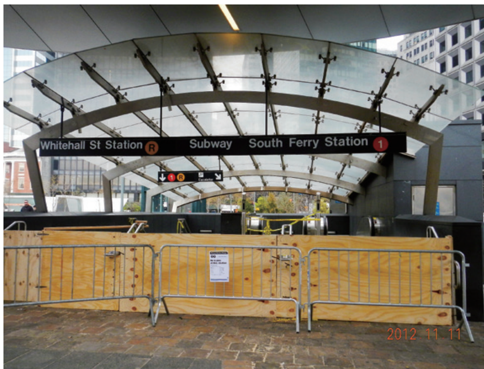
図5 サンディ高潮により浸水したニューヨーク市の地下鉄駅の例
