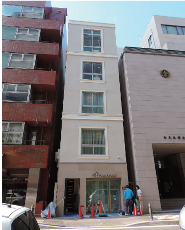
図1 銀座に竣工した木造耐火建築
