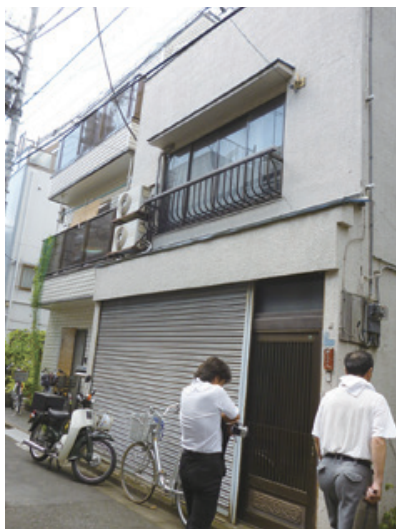
(a) 耐震・防火補強前
