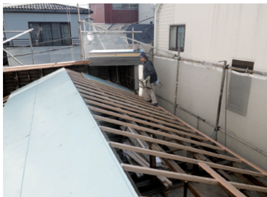
(a) 屋根の葺き替え・軽量化
