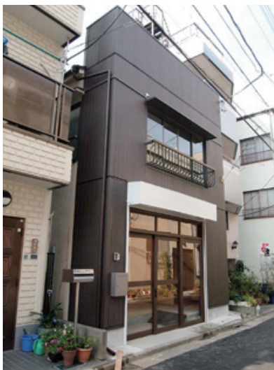
(b) 耐震・防火補強後
