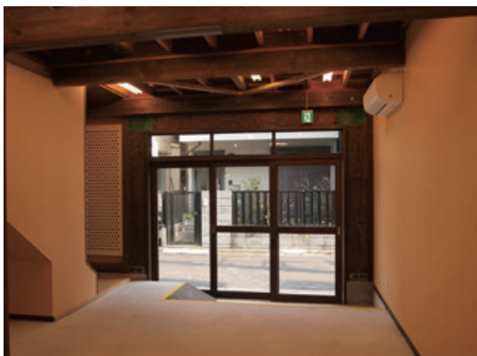
(b) 補強後の室内（道路を見る）
