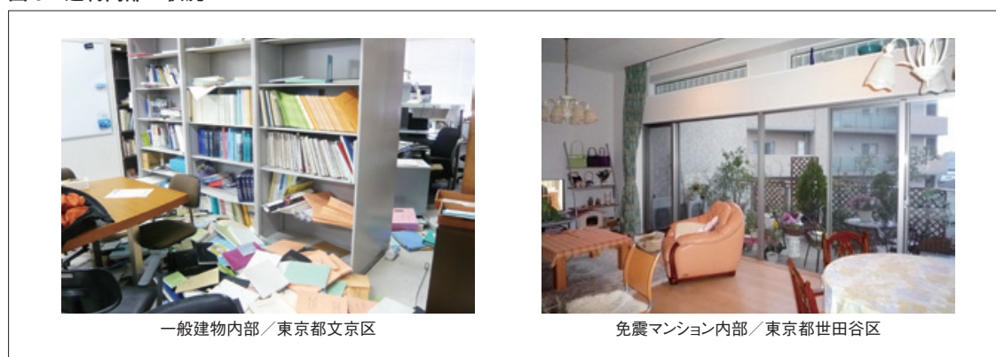
図5 建物内部の状況
