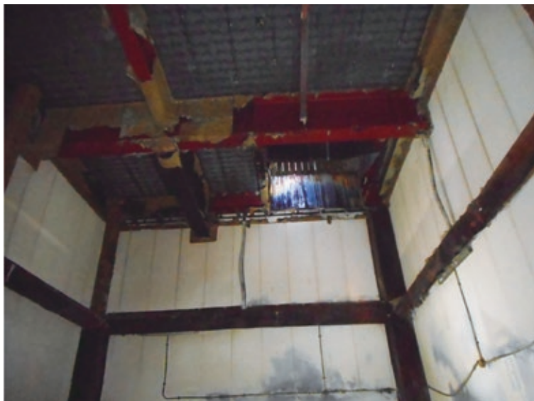
図4 出火した端材処理室（天井右下に2階倉庫への開口）
