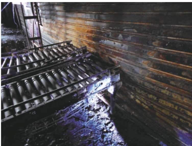
図1 正常に降下した防火シャッターとローラーコンベヤ
