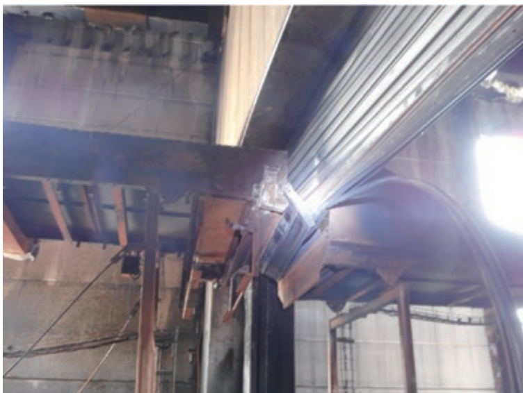
図2 ベルトコンベヤによる防火シャッターの閉鎖障害
