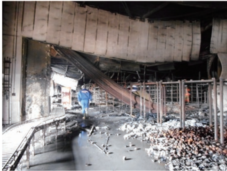
図5 防火シャッターのある壁の崩壊（シャッターは不作動）
