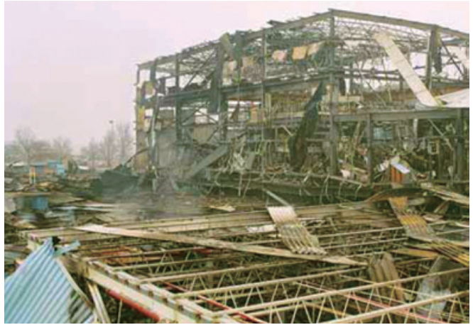
図2 粉じん爆発 軽量の壁面、天板は破損・飛散するが鉄骨は残存している
