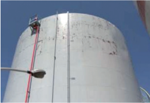
図9 不等沈下による配管のストレス
