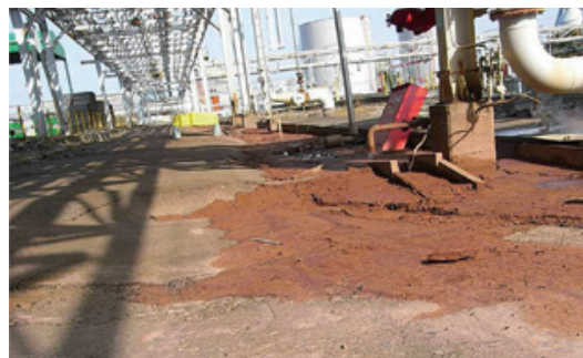
図5 液状化によるパイラック下道路陥没 —パイラック本体(杭基礎)に影響なし
