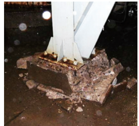
図7 鉄架構柱脚部の基礎立ち上がり(アンカーボルト)部の破損
