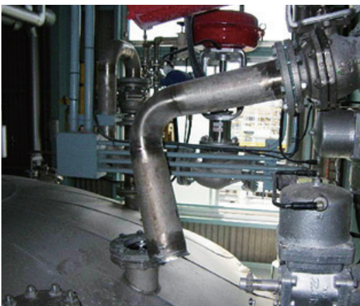
図4 ベッセル上部配管の破損
