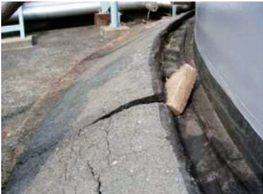
図10 500klタンクの底盤部の破損 (アスファルト膨らみ)
