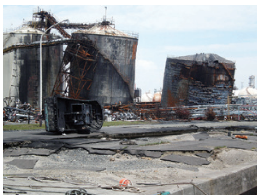
写真6 津波により倒壊し燃えたタンク
