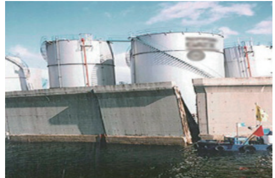
写真3 護岸の被害
