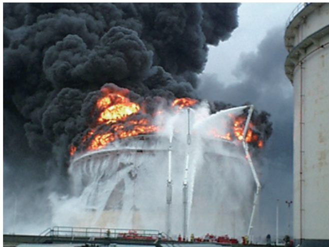
写真4 火災時のナフサタンクの状況
