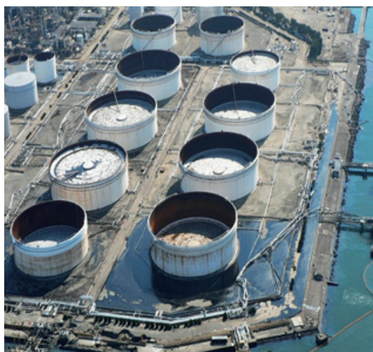
写真5 配管の破断(仙台)
