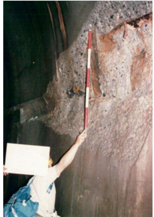
図2 覆工のひび割れと落下の可能性のあるコンクリート片
