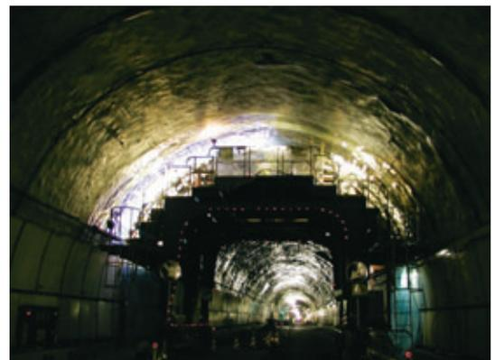
図5 盤膨れ補修工事
